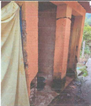
Foto 3: Mejoramiento de servicios sanitarios
