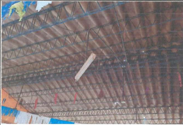
Foto 1: Instalación de lamina troquelada calibre 26
