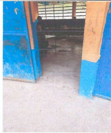
Foto 2: Mejoramiento del piso
