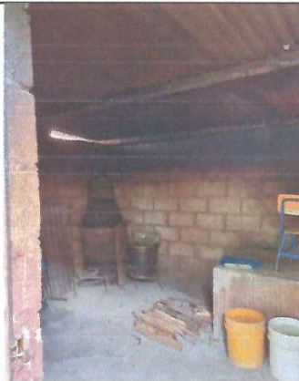
Foto 4: Mejoramiento del área de cocina.
